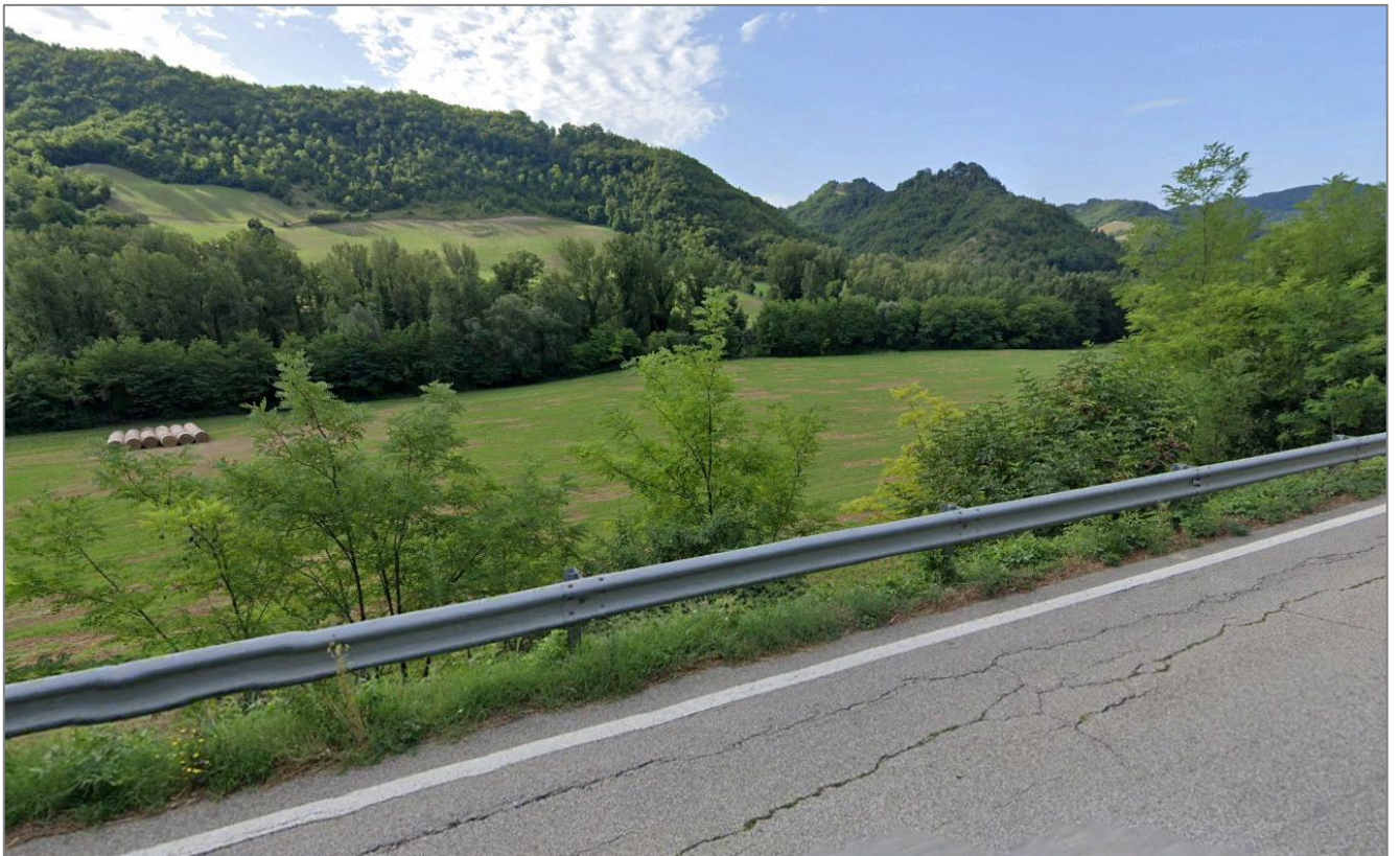
U.M.I. 3: "Fabbrano" Vista panoramica da nord verso sud
