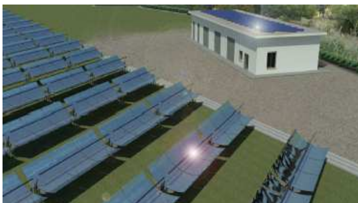
Dettaglio del parco solare nei pressi del locale tecnico Sul tetto del locale tecnico c'è il piccolo impianto fotovoltaico per l'auto produzione di E.E. da fonte solare
